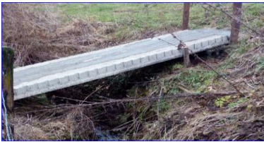
nouveau ponceau à Panneswei
